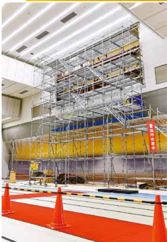
拆除工作從搭建腳手架開始進行。將要安裝的新的大型視頻圖像將保持相同的呎吋，但LED燈的數量增加了25倍，圖像更加清晰。
